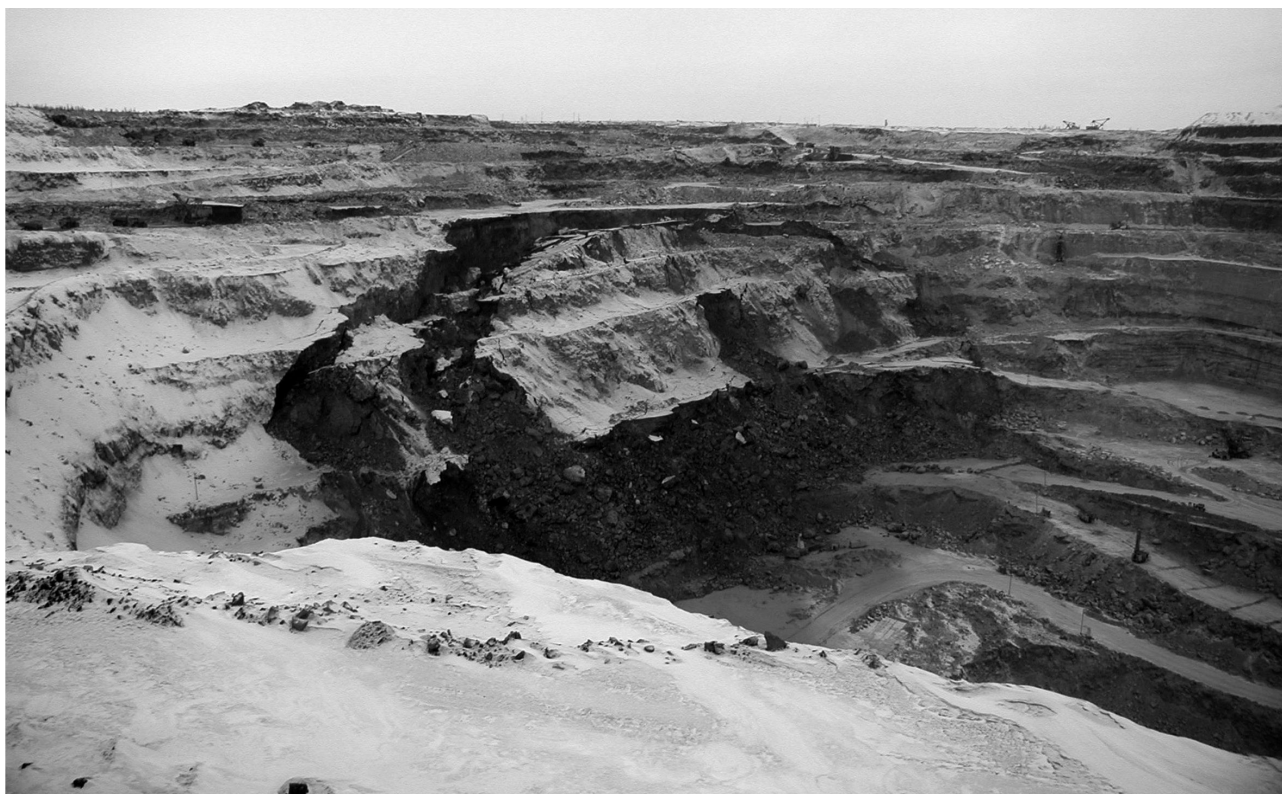
Рис. 1. Обрушенный участок борта карьера «Юбилейный» (Западная Якутия, п. Айхал) в мерзлых породах.
