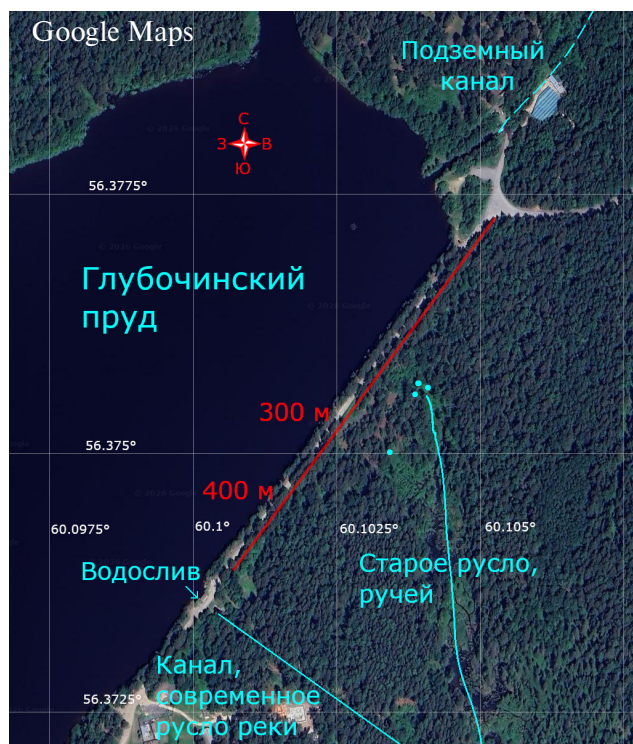
Рис. 7. Профиль исследований на Глубочинской плотине.
