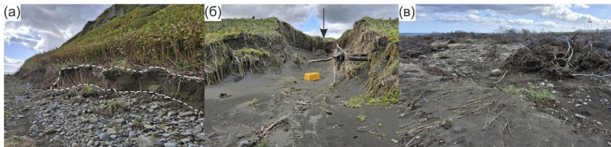
Рис. 5. Сильная эрозия в долине р. Северянка: размыв подошвы склона (а); промоина в береговом валу (б); глубокие промоины с аккумуляцией в них гальки и вырванный с корнями ольховый стланник (в).
