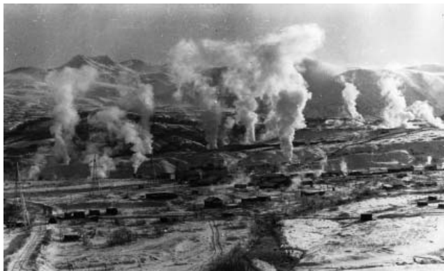
Рис. 1. Паужетское геотермальное месторождение. Пробные выпуски пара из разведочных скважин. Фото из архива В.М. Сугробова
